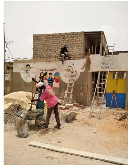
Construction de la nouvelle classe de CM2 pour l'école Keur Aminata au Sénégal
